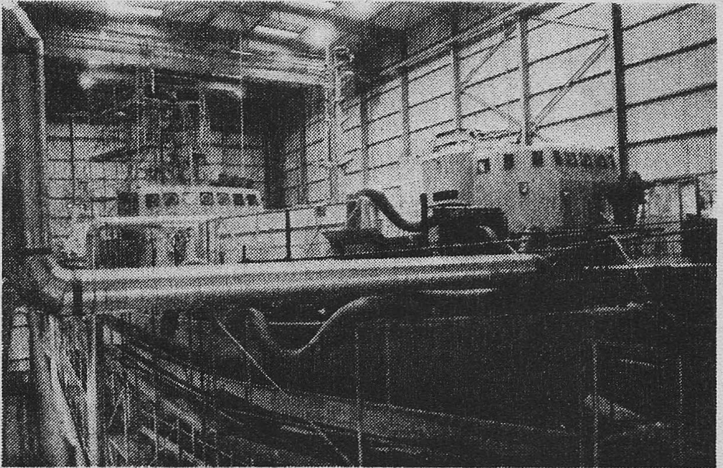
Zwei Schnellboote der Bundesmarine werden von der kommenden Woche an auf der Kröger-Werft in Schacht-Audorf von asbesthaltigen Dämm- und Isoliermaterialien befreit. Die als „Pilotprojekt“ proklamierte aufwendige Sanierung der in Olpenitz stationierten Boote „Falke“ und „Marder“ soll Aufschluß darüber geben, wie die Boote und Schiffe der Marine künftig in großem Stil von dem krebserregenden Stoff entsorgt werden können.
