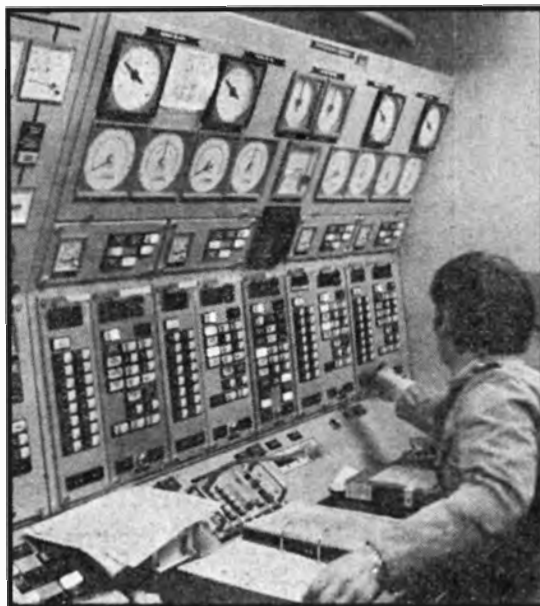
Vom Leitstand aus werden die vier Dieselmotoren gesteuert: 18 000 PS stecken im Boot
